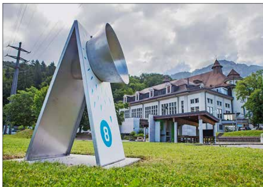
Le parcours présente les activités et l'environnement de la centrale hydroélectrique de Broc. CHLOÉ LAMBERT
